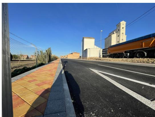
inició con el nivelado del nuevo vial, asfaltado y acerado y servicio de alumbrado público. Se elimina de este modo una zona de barro, tierra y charcos para obtener un vial que enlaza las urbanizaciones Ntra. Sra. de la Piedad, Garrigal y Ventana con la carretera o Avda. de la Constitución, principal arteria de nuestro pueblo, facilitando así la movilidad de todos los vecinos en esta zona.
